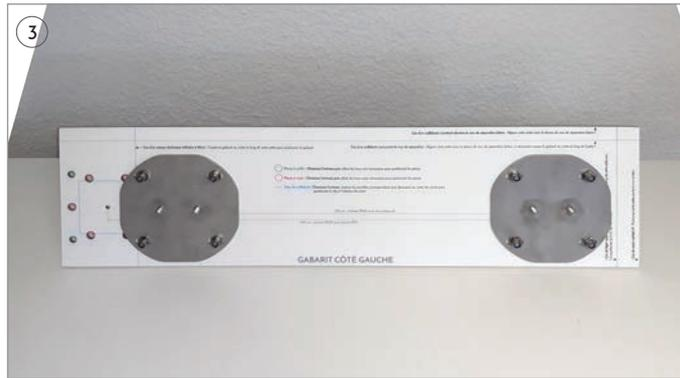
Coulez un béton de densité  $350 \text{ kg/m}^3$  dans les zones carottées puis venez y insérer le gabarit avec les PASV.
